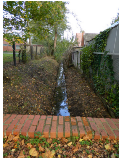
Zustand der „Alten Kollau“ am Wehmerweg nach der Grundsanierung
