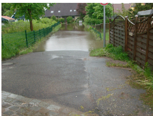
Flutung des westlichen Teils des Wullwisch (Blick vom Wehmerweg)
